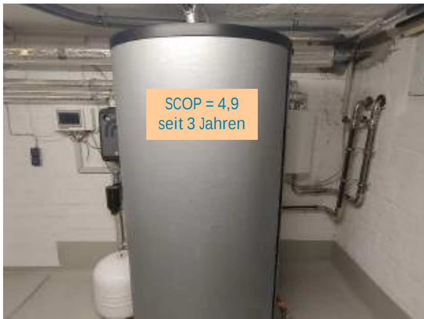
So einfach kann eine Hygiene-Kombispeicher-Installation sein
